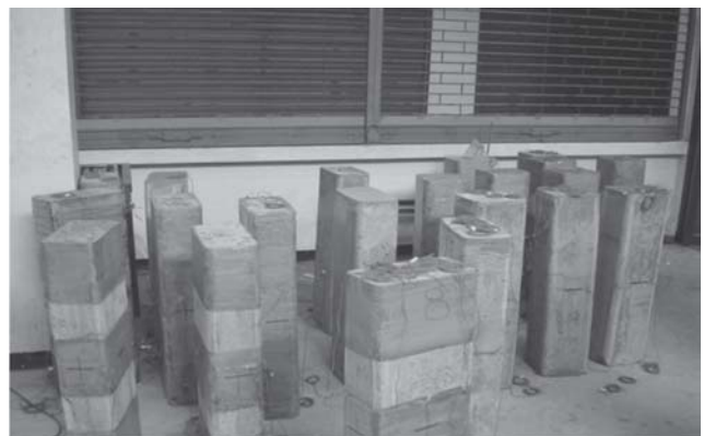
ภาพที่ 7 การหุ้มคาร์บอนไฟเบอร์เสาคอนกรีตเสริมเหล็ก
