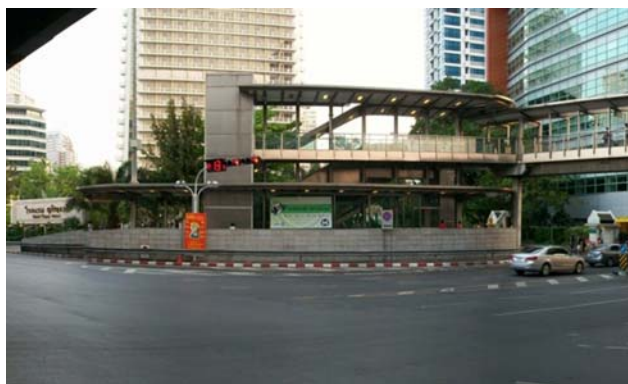
ภาพที่ 4 รูปถ่ายบริเวณประตู 2 สถานีสีลม
